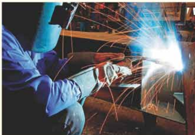
Công nhân Xí nghiệp Chế tạo thiết bị lắp máy và điện, đang gia công lắp ráp kết cấu Zamin, phục vụ thi công nhà xưởng có khẩu độ lớn 36 đến 42 m
