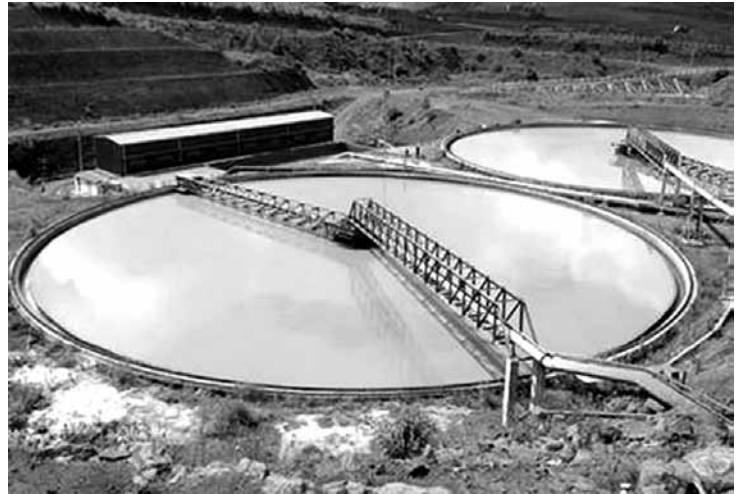
▲ Khu bể lắng tại Nhà máy tuyển quặng bô xít Tân Rai
