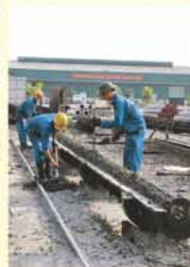
Sản xuất cột điện bê tông ly tâm
