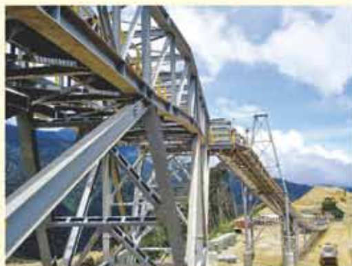
Một công trình băng tải do XN Chế tạo thiết bị lắp máy và điện thi công
